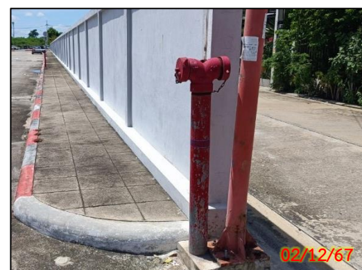
รูปที่ 2.2-6 หัวรับน้ำดับเพลิงภายในโครงการ
